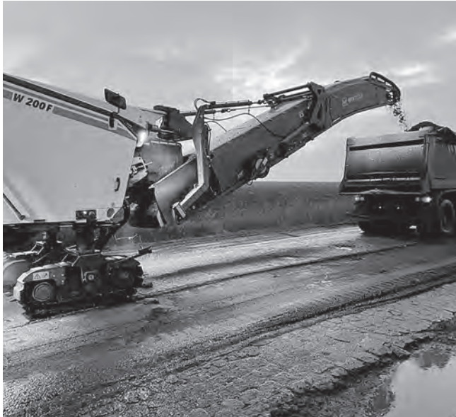
Ремонт автодороги до с. Полтавка
