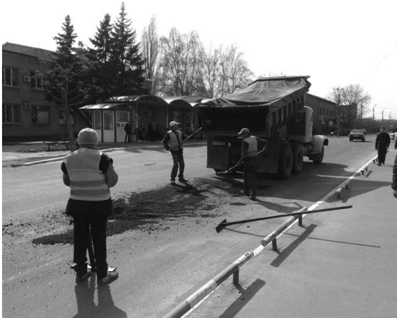
На пересечении улиц Европейской и Маршала Москаленко работала бригада дорожников и три единицы техники
