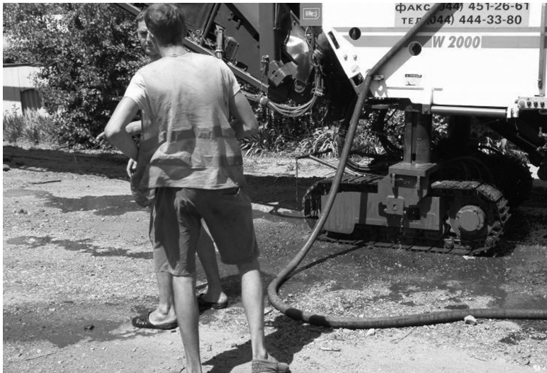
Ремонт путепровода, который соединяет Покровск и Мирноград
