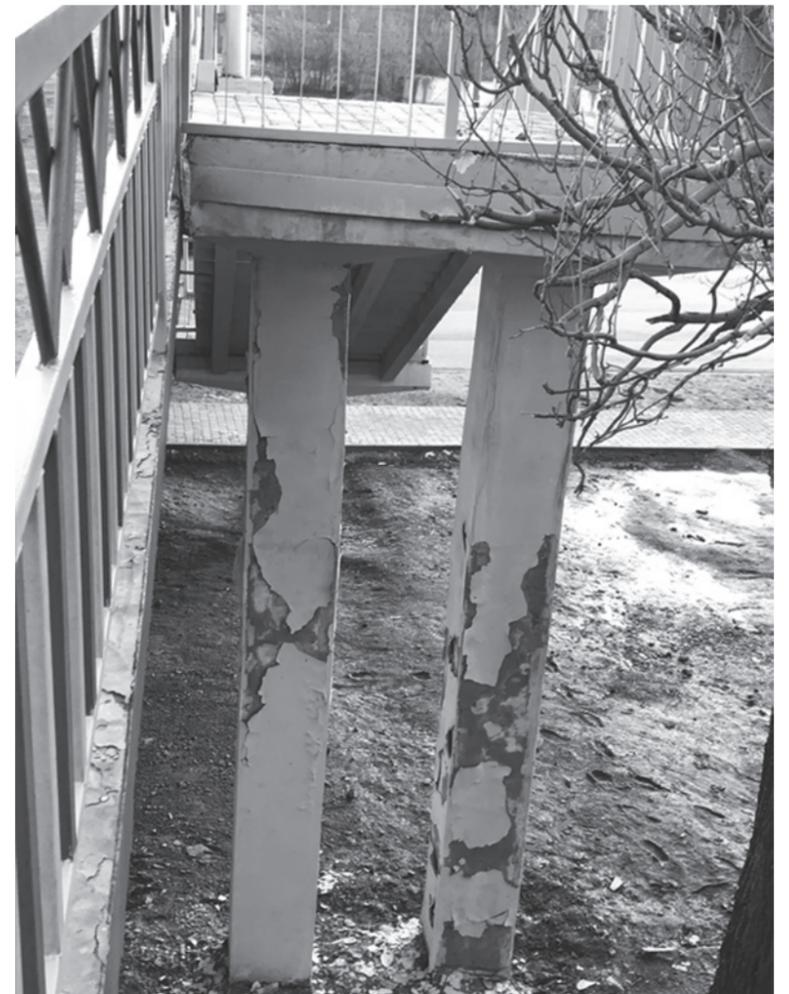
На опорных конструкциях сооружения повсюду осыпается штукатурка
