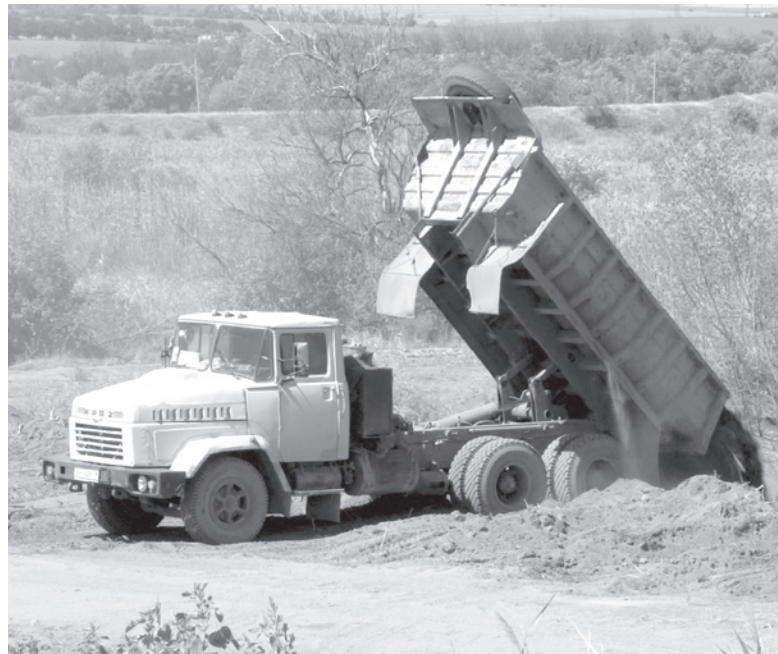
Один из источников зловонного запаха уже засыпали
