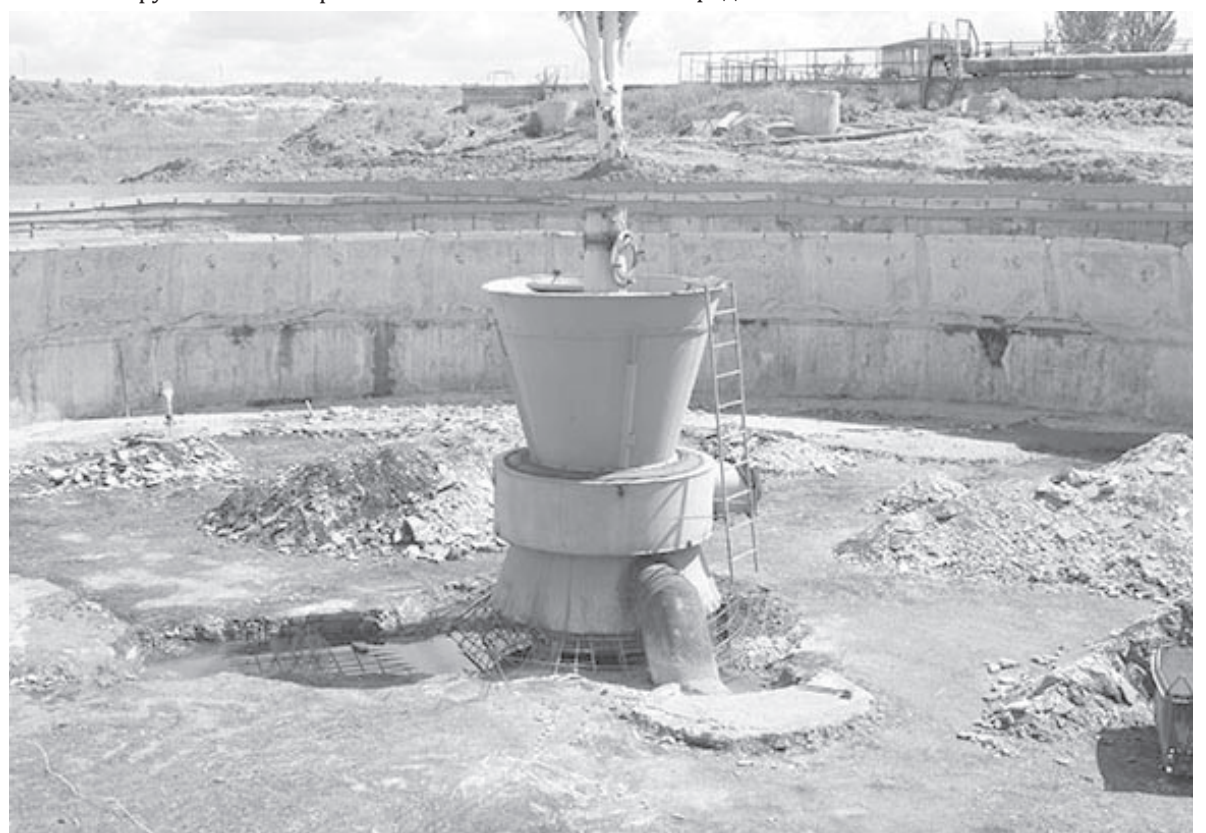
Реконструкция вторичного отстойника пока не завершена
